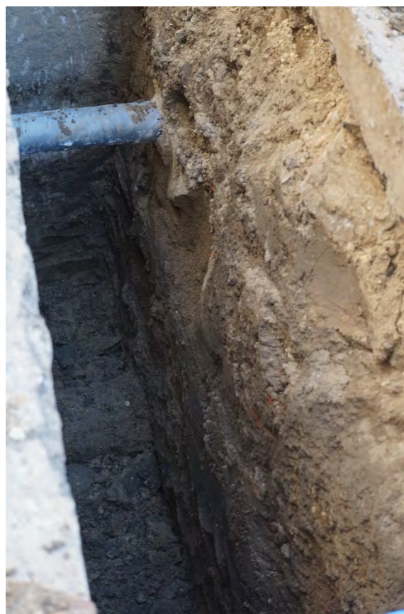
Fig. 11a. Șanțul de poziționare a cablurilor cuprins între structura fortificației bastionare din Piața Mărăști și intrarea Facultății de Arte. Detaliul profilului stratigrafic.
