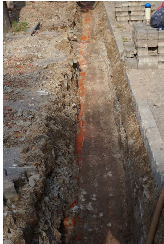
Fig. 14a. Șanțul de poziționare a cablurilor cuprins între Căminul nr. 6 și nr. 7 de pe strada Oituz, unde au fost identificate structuri ale fortificației bastionare (vedere dinspre est).
