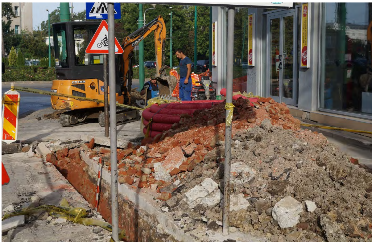
Fig. 10. Șanțul de poziționare a cablurilor cuprins între Căminul nr. 4 din Piața Mărăști. În capătul vestic al acestuia au fost identificate structuri ale fortificației bastionare.
