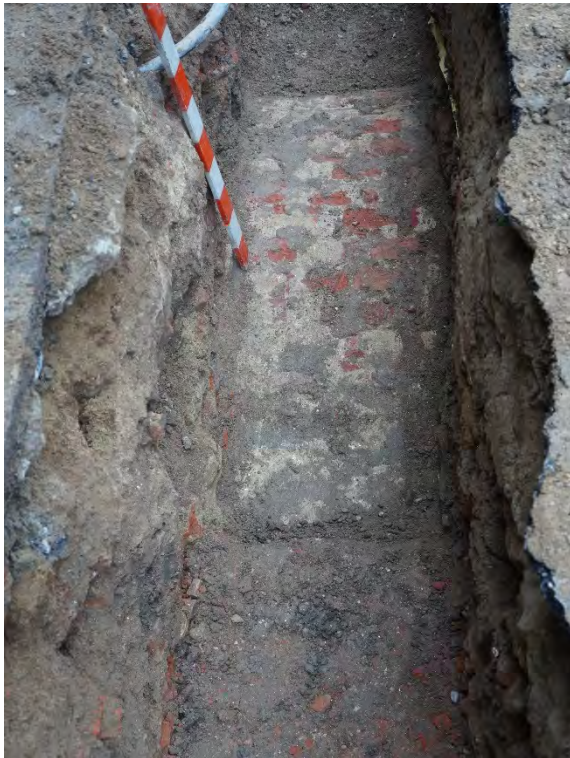
Fig. 8c. Detaliul structurii boltite situate în apropierea intrării în curtea Spitalului Municipal.
