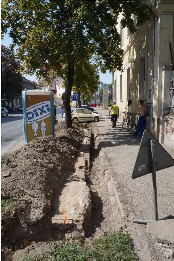
Fig. 16. Șanțul de poziționare a cablurilor cuprins între Căminul nr. 7 și nr. 8 de pe strada Oituz, unde au fost identificate structuri zidite (vedere dinspre est).
