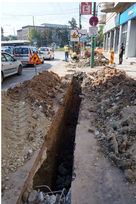
Fig. 11. Șanțul de poziționare a cablurilor cuprins între structura fortificației bastionare din Piața Mărăști și intrarea Facultății de Arte, în care nu au fost identificate structuri ale fortificației bastionare.
